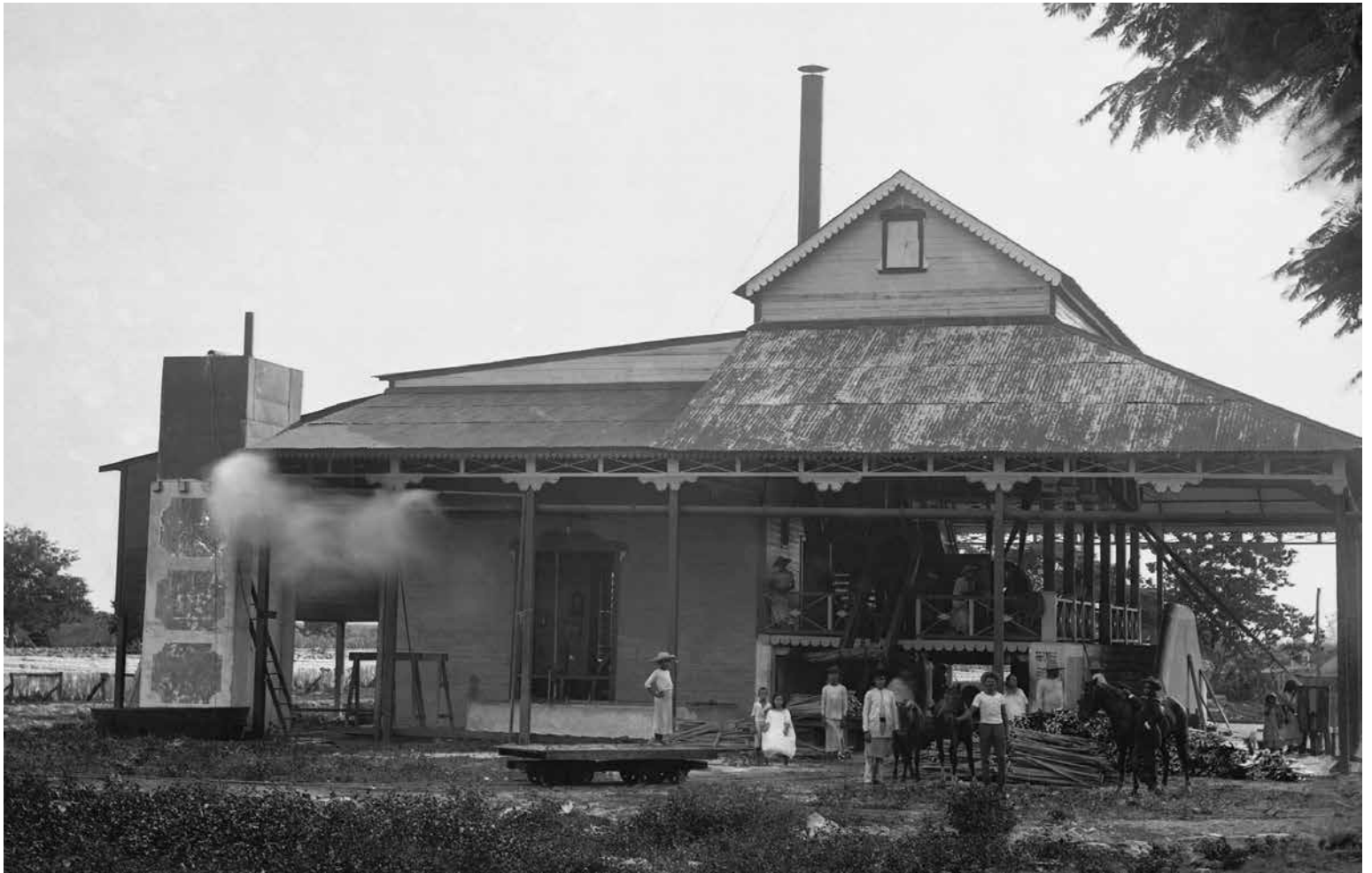
Figura 3. La bomba de agua movida con vapor desplazó a la noria para el desarrollo de la industria henequenera en el siglo XIX.
