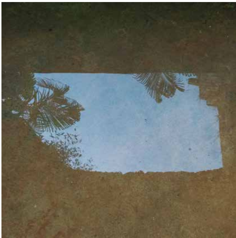
Figura 11. Reflejo de gárgola o conducto de desagüe en un charco del convento de Maní.
